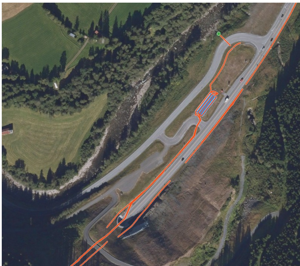
Figur 1 Vannhåndteringsanlegg ved Soknedalstunnelen på E6 i Trøndelag (Foto: vegkart.no)
