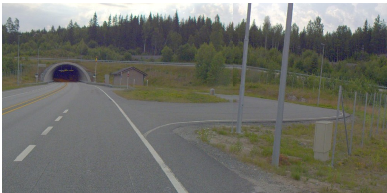
Figur 1 Trafikklokke (Foto: Statens vegvesen)
