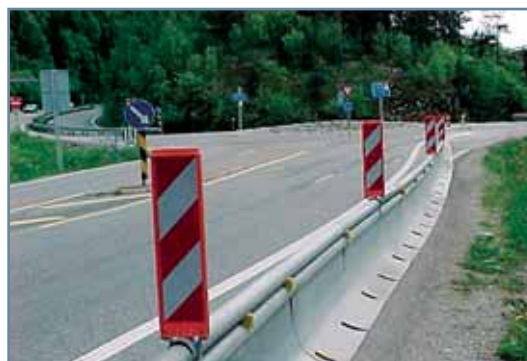
Figur 4.12: Langsgående sikring (eksempel)
