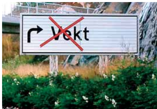
Figur 4.6: Eksempel på bruk av tape for å sette skilt ut av funksjon
