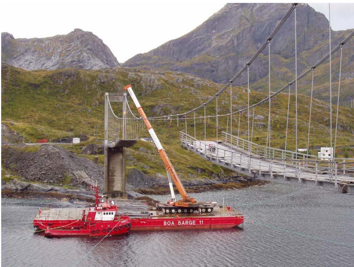
Demontering av brudekke
